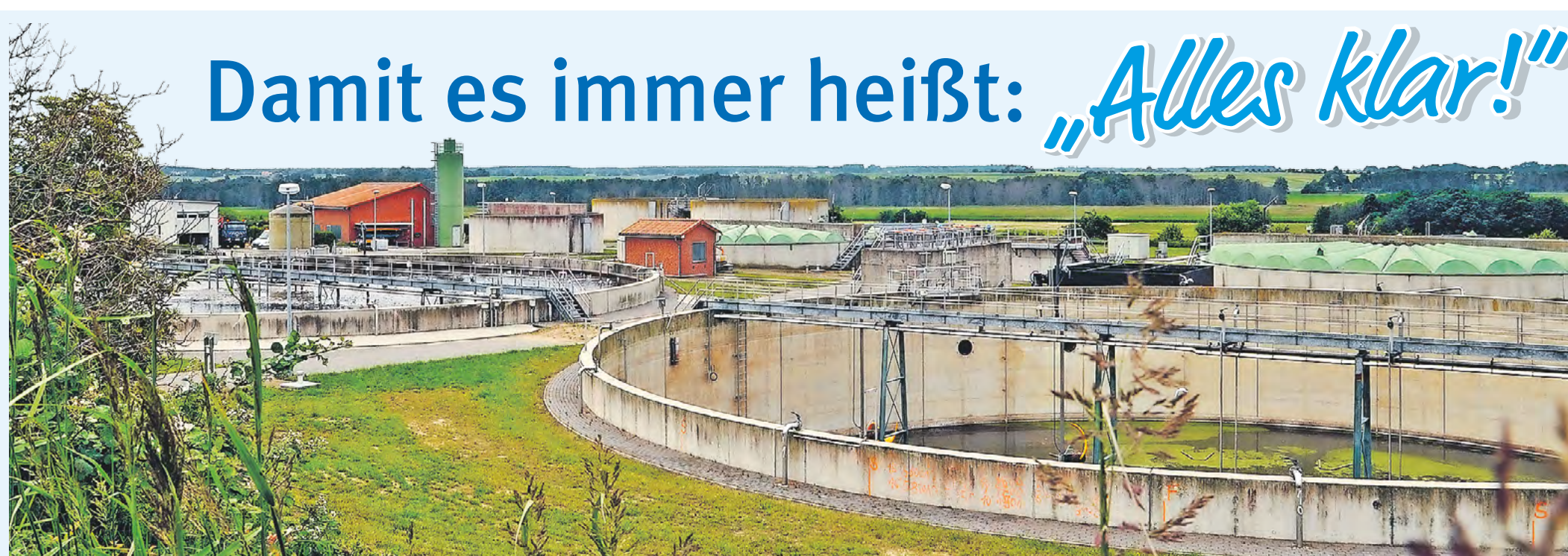
In der Kläranlage Wolgast werden die Abwasserinhaltsstoffe zu 94 Prozent entfernt, ehe sie im Anschluss an die Nachklärung in die Vorflut des Flüsschens Ziese eingeleitet werden.
