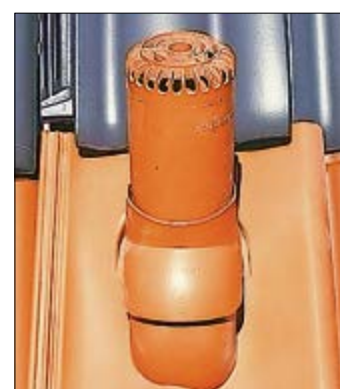
Rohr ohne Wetterhaube.
