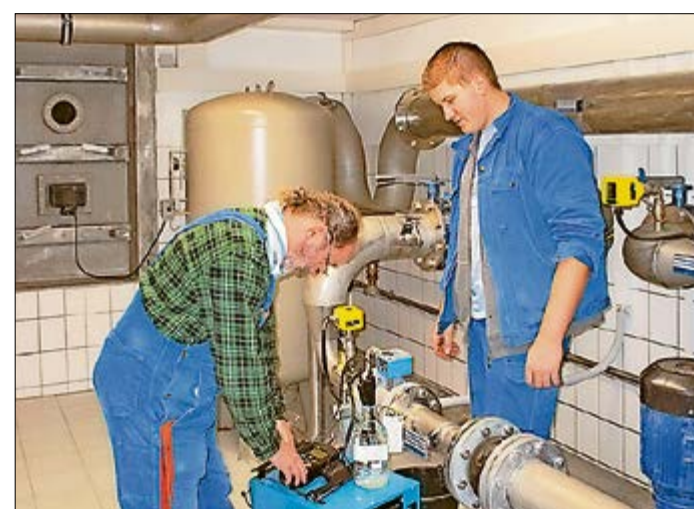
Für Reiner Gennrich (li.) und Patrick Pogrzeba gehört die regelmäßige Probenentnahme von Trinkwasser zum Arbeitsalltag. Mit moderner Messtechnik lassen sich die Werte an Ort und Stelle überprüfen.
