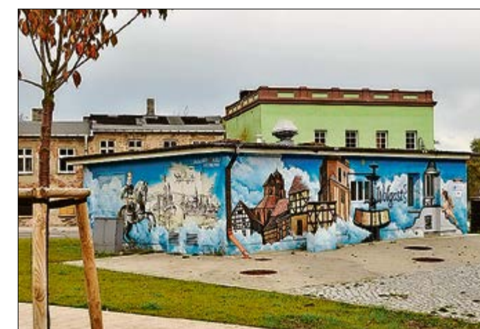
Noch steht der oberirdische Bau des Hauptpumpwerks gut sichtbar in der Wilhelmstraße. Zu Gunsten einer geschlossenen Pumpenanlage soll der Bau aber einer Betondecke weichen.
