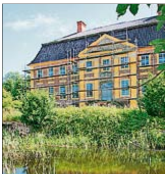
In zwei Jahren soll die 2015 begonnene Sanierung abgeschlossen sein. Foto: SPREE-PR/Galda
