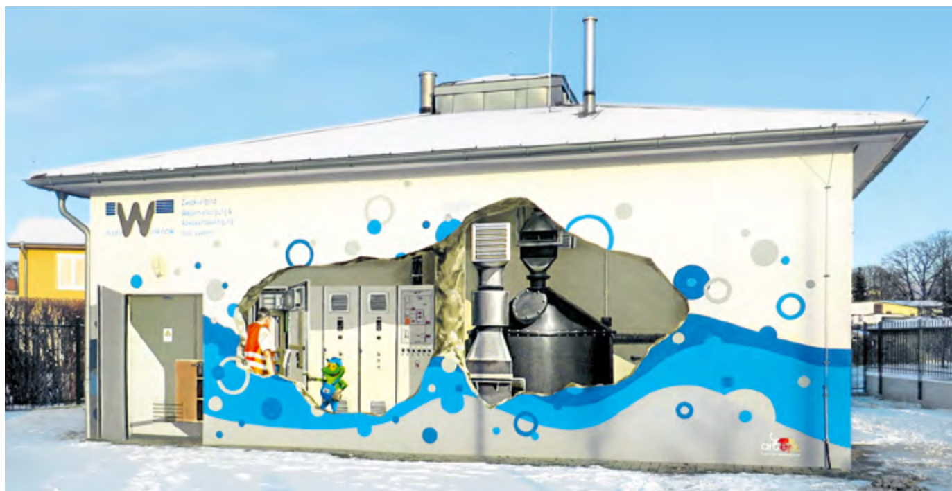
In Ahlbeck erlaubt die Gestaltung des Abwasser-Pumpwerks ungewohnte Einblicke. Der Zweckverband Usedom zeigt so realitätsnah die Technik der Anlage, dass Kunden schon die Frage stellten, warum denn die Tür immer geöffnet sei ...
