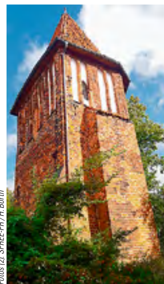
Seinen Platz hat der alte Wasserturm am Lindengarten.
