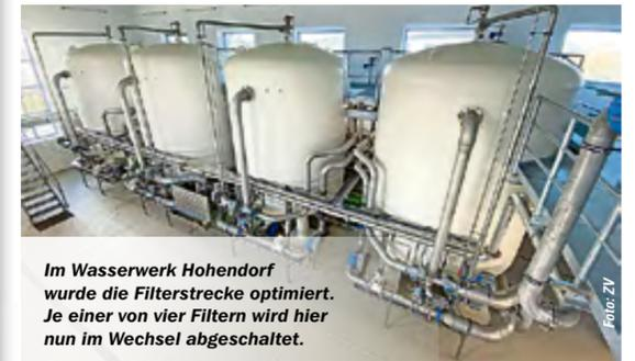
Im Wasserwerk Hohendorf wurde die Filterstrecke optimiert. Je einer von vier Filtern wird hier nun im Wechsel abgeschaltet.
