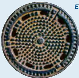
**EINSTIEGSCHACHT.** Jeder Kanal hat ca. alle 60 m eine Öffnung nach oben. Dadurch können Kanalarbeiter einsteigen, den Kanal lüften, Reinigungsgeräte runterbringen, Verstopfungen beseitigen und Kanalschlamm entfernen.
