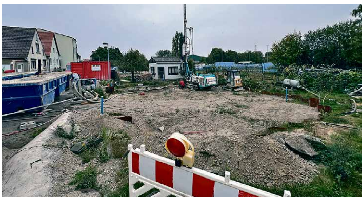
Die Baustelle in der Fischerstraße geht weiter – nach mehreren Monaten Verzögerung.
