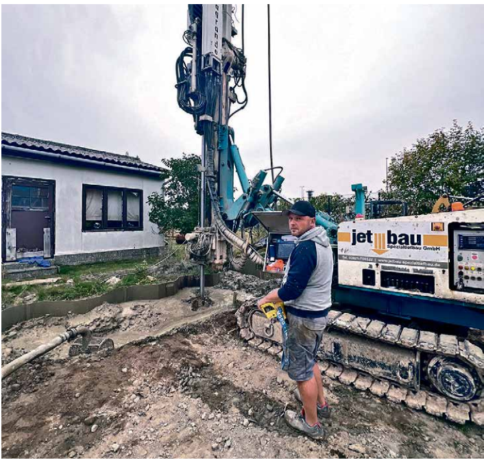
Der schwierige Untergrund erfordert schweres Gerät für die Gründung der Sohle des Regenrückhaltebeckens.
