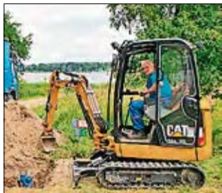
Olaf Segebrecht beim Bagger-einsatz. Foto: Zweckverband Wolgast
