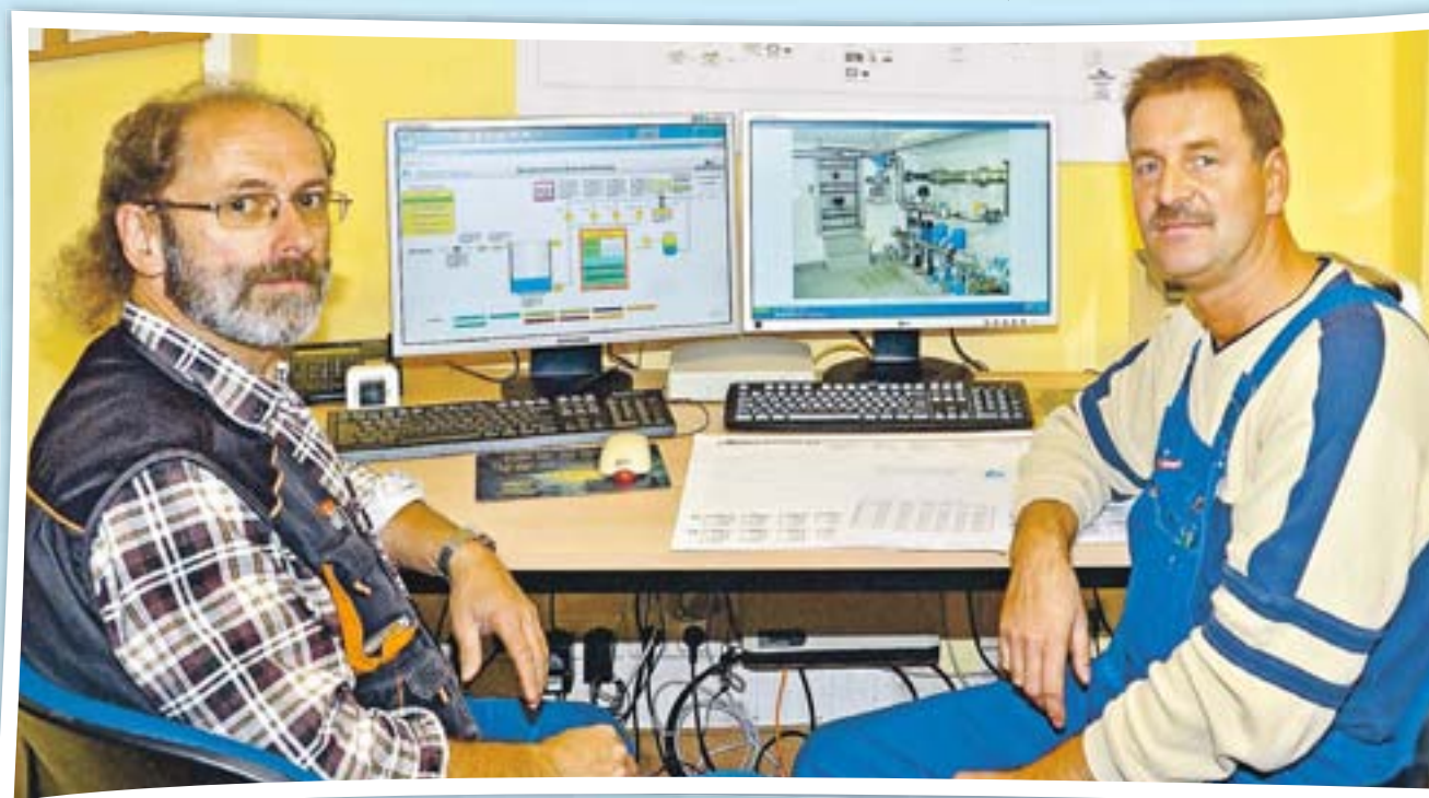
Sie überwachen Leitungssysteme und Anlagen: Meister Fred Witteck (rechts) und Elektriker Reiner Gennrich am Prozessleitsystem in der Druckstation Bahnhofstraße.
