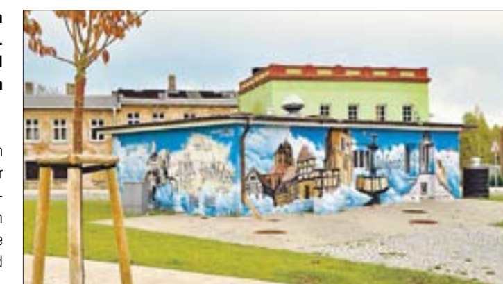
Das Pumpwerk wurde bereits 2007 künstlerisch gestaltet.
