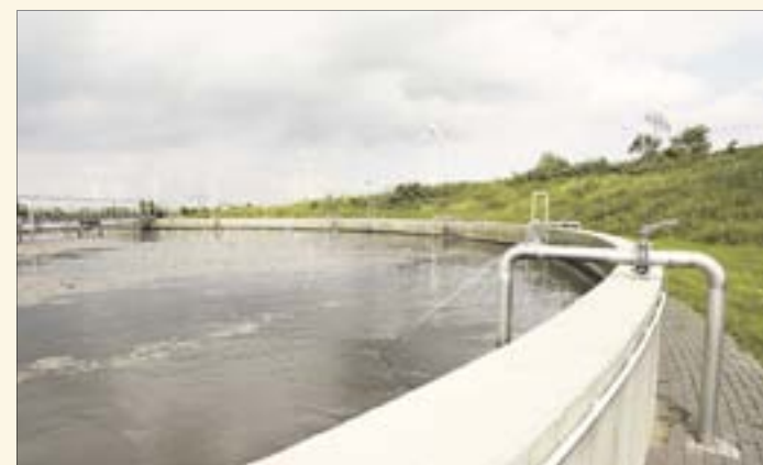
Die Kläranlage reinigt auch das Abwasser des Inselnordens.
