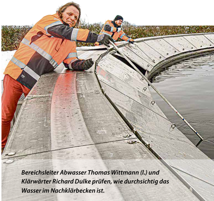
Im Belebungsbecken sind Bakterien die wichtigsten Mitarbeiter. Der Belebtschwamm sinkt später zu Boden. Oben entsteht klares, reines Wasser.
