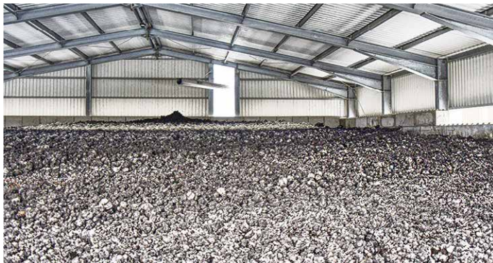
Das Schlammager fasst etwa 1.000 Tonnen. Etwa zweimal im Jahr wird das Lager geleert.
